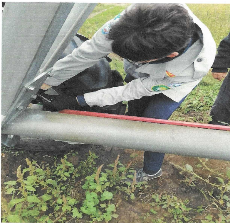
Ремонт дождевальной машины
